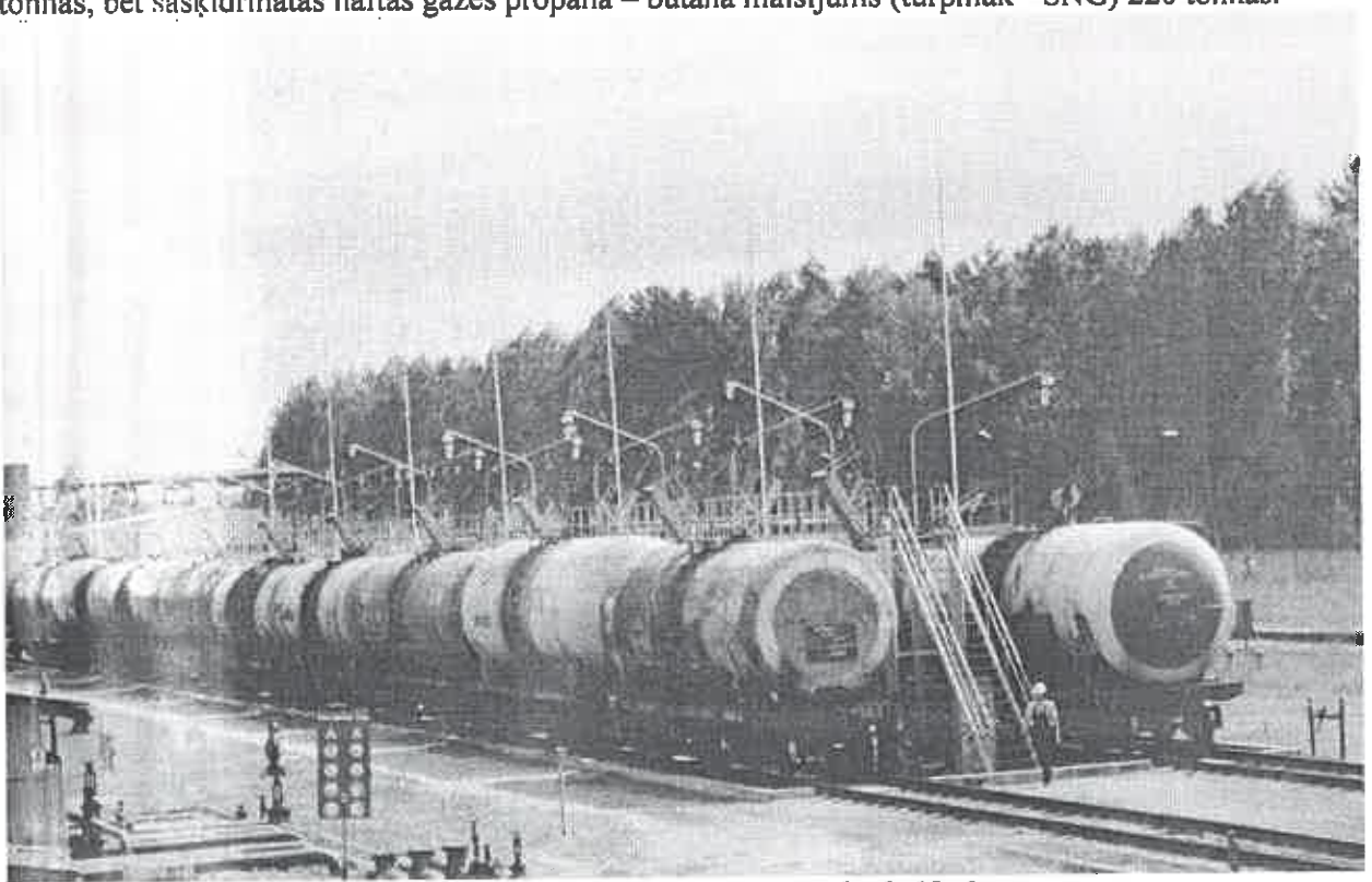
1.2.attēls dzelzceļa cisternu estakāde Nr.1.
