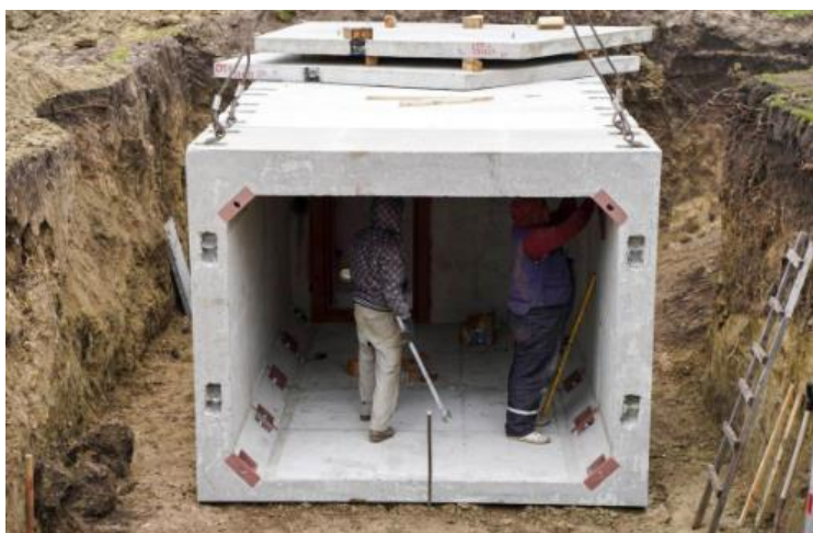
Attēls. Dzelzsbetona bloku konstrukcijas 7
